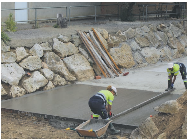
TRABAJADORES DEL TALLER DE EMPLEO EJECUTANDO LAS OBRAS / DD
