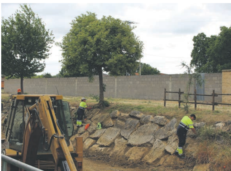
TRABAJOS DE RESTAURACIÓN DEL CANAL / DD
