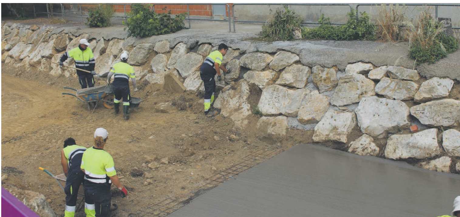
TRABAJADORES DEL TALLER DE EMPLEO EN LAS OBRAS DE MEJORA DEL CANAL MOLINO VIEJO / AECT Duero-Douro
