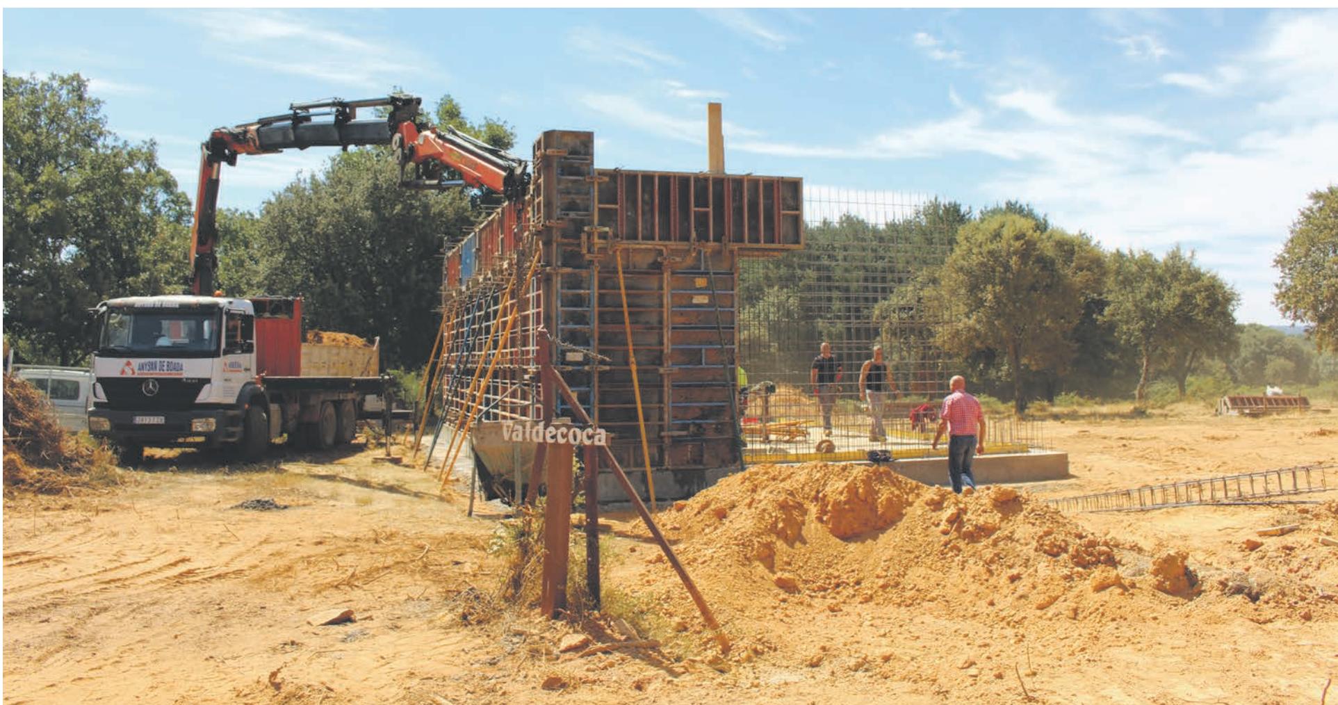
OBRAS DE CONSTRUCCIÓN DEL NUEVO DEPÓSITO EN ROBLEDA (Salamanca) / AECT Duero-Douro
