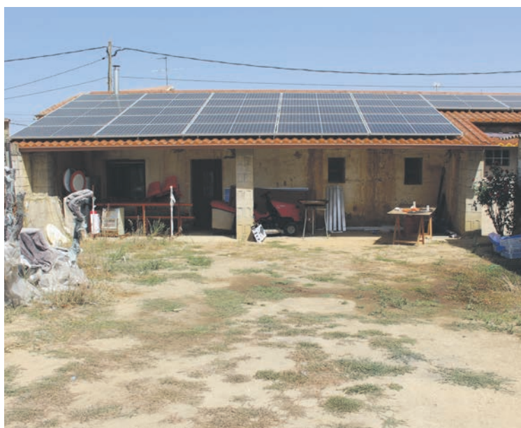
PARCELA DONDE SE UBICARÁ LA NUEVA NAVE MUNICIPAL / AECT Duero-Douro
